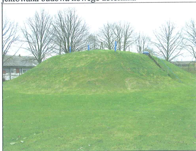
Fot. 3. Przysypany zbiornik retencyjny wody – projektowana budowa nowego zbiornika
