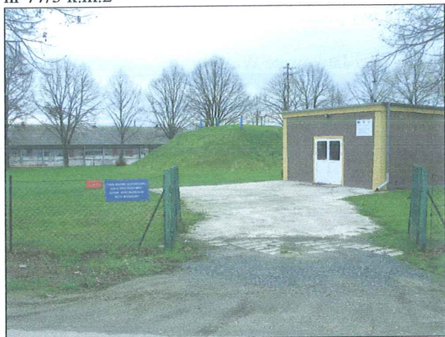
Fot. 2. Zjazd na teren stacji uzdatniania wody na dz. nr 77/3 k.m.2
